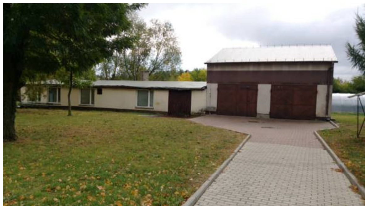
Istniejący budynek starej pralni (część niższa) i garażu (część wyższa) str. północna
