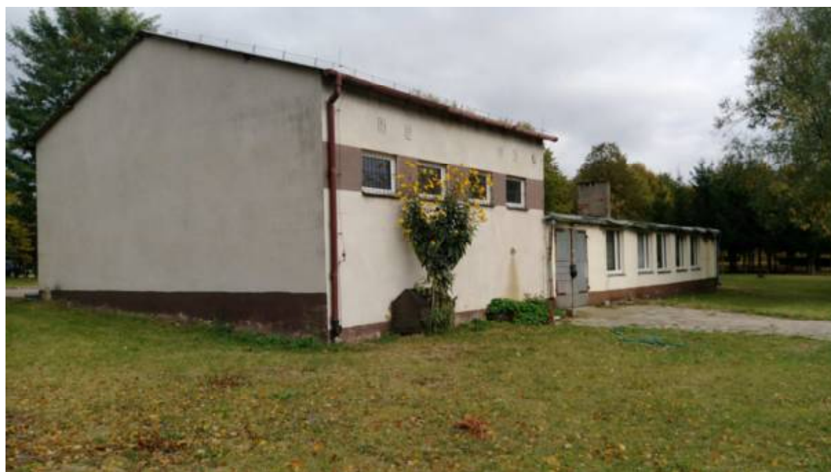
Istniejący budynek starej pralni (część niższa) i garażu (część wyższa) str. południowa
