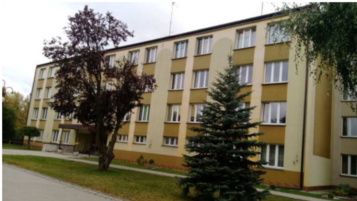
Budynek "A" (mieszkalny) - strona zachodnia
